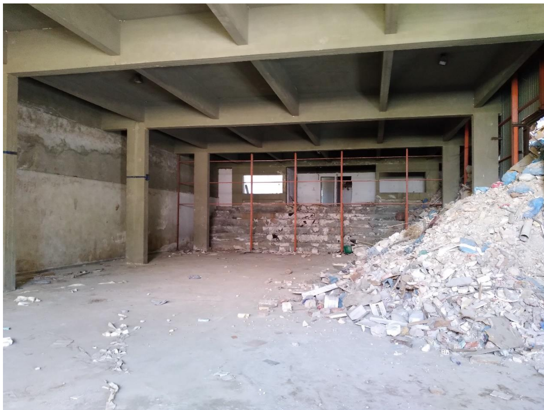
Εικόνα Π-4: Άποψη των απορριμματικών αποθέσεων εντός κτιρίων στην 1 η θέση πρώην ΟΑΕΔ
