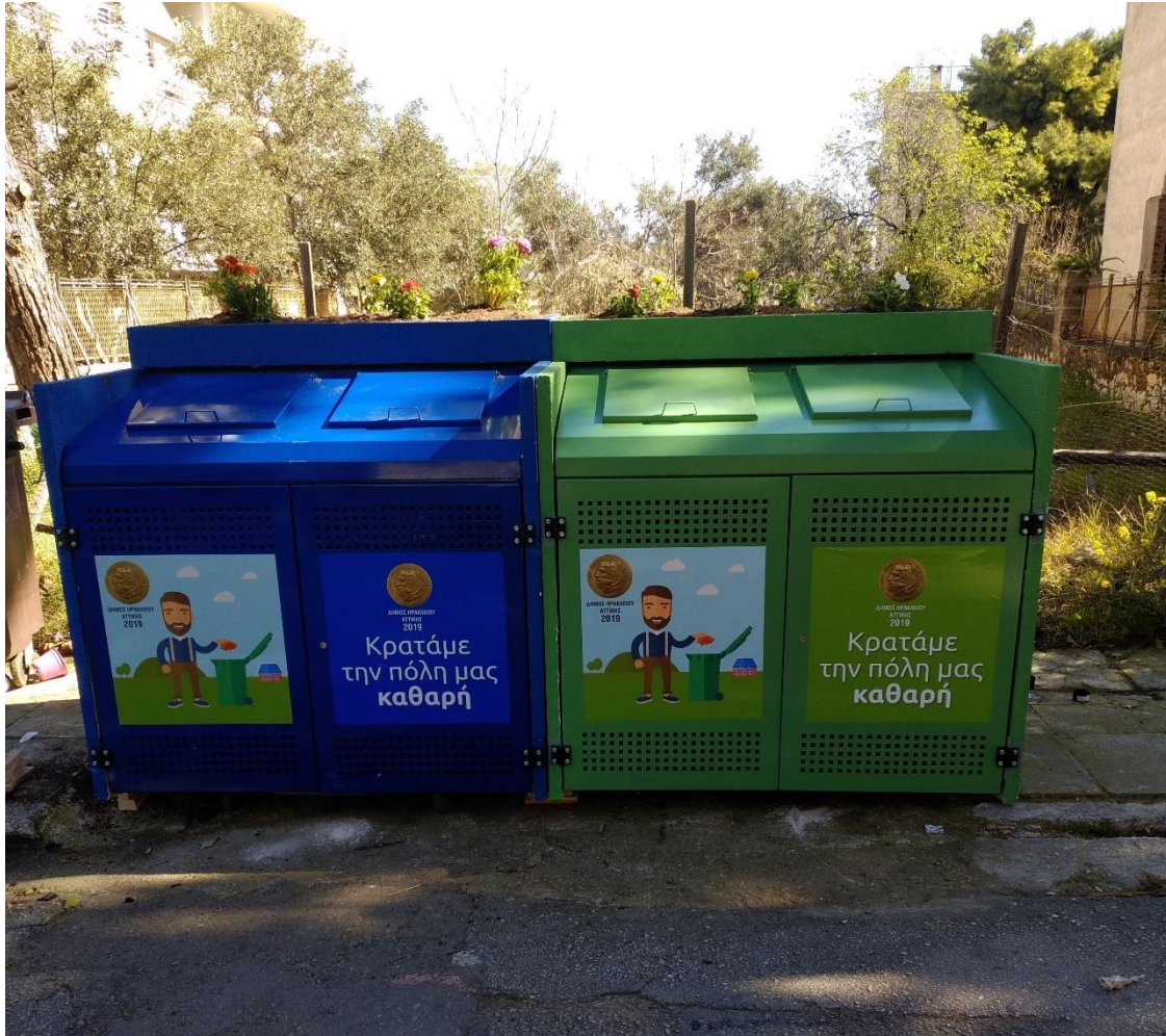
Εικόνα 8-1: Κατασκευές για κάδους 1.100lt από μπετό και σίδηρο (σε οικισμούς)
